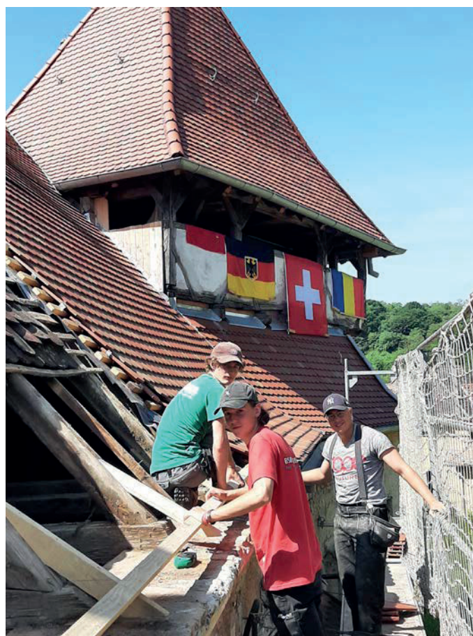
Verlegen der Ziegel auf dem Pfarrhaus.
