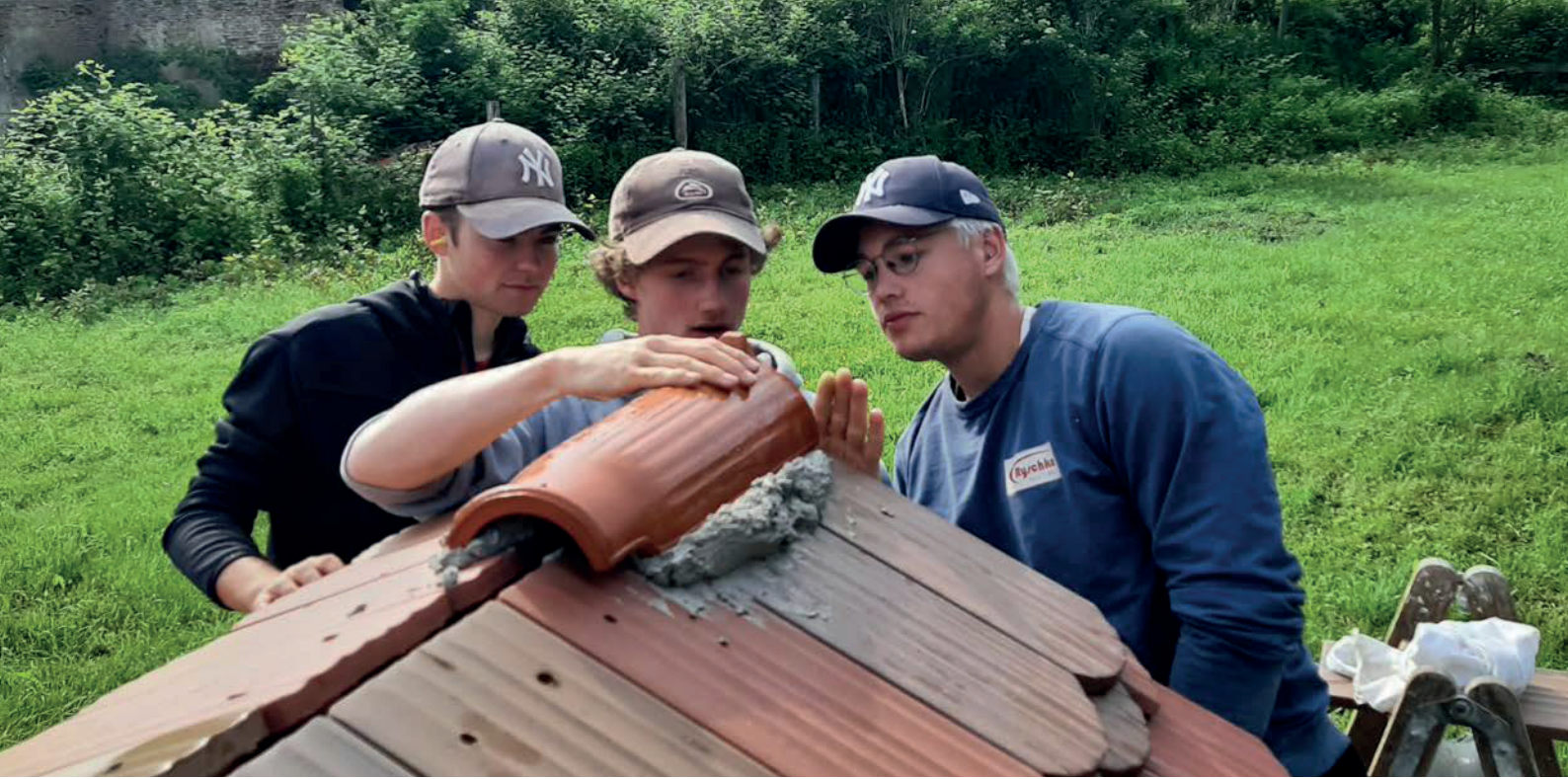
Erstellen des Firstes am Brunnen.
